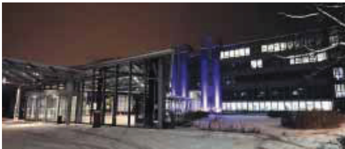
Lichteffekte am Aufzugsschacht: Skylight sorgt am ABC-Gebäude für einen blauen Zauber.
